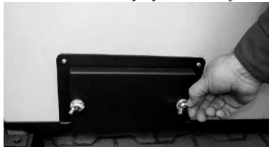
Demontaż wyczystki bocznej
