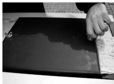
Czyszczenie kanałów konwekcyjnych
