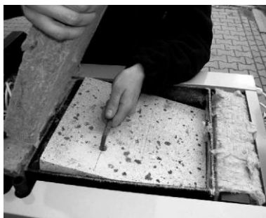
Demontaż wyczystki bocznej
