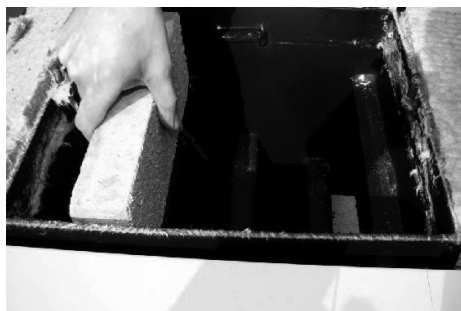
Czyszczenie wyczystki bocznej
